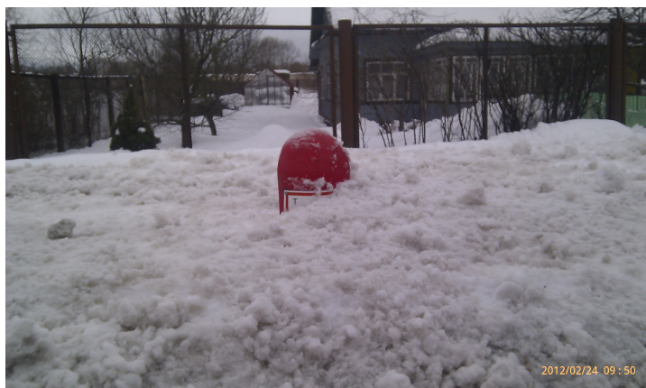
Joonis 13. Raskendatud ligipääsuga hüdrant talvisel ajal
