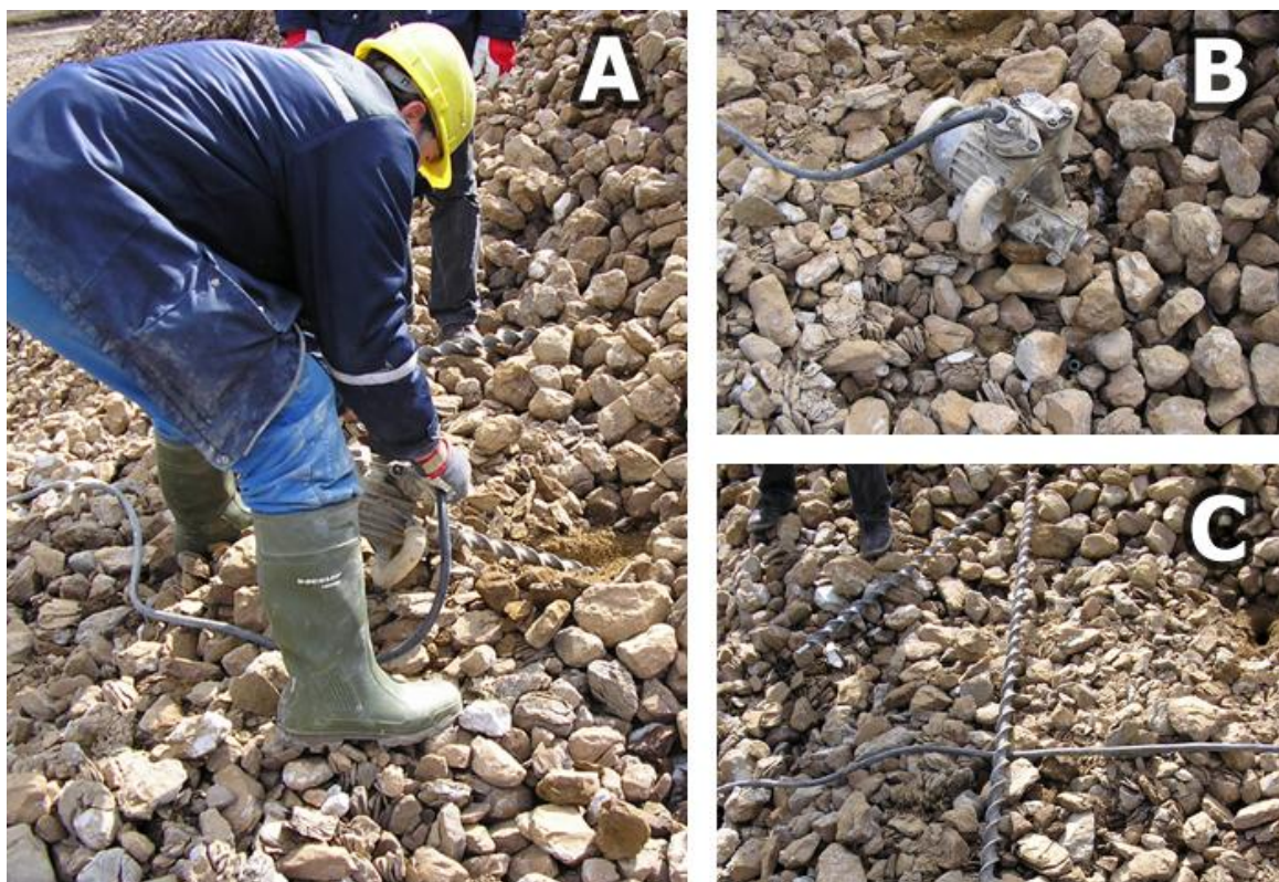
Joonis 7. A: Kanali puurimine põlevkivis. B: Elektriline käsipuur CЭP-19M. C: Kaks puuri 1,0 m ja 2,0 m pikkusega (autori joonis)
