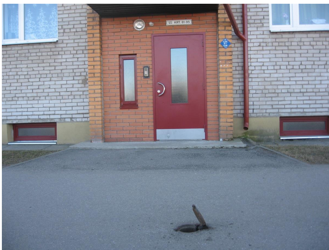
Joonis 9. Elamurajoonides paiknevad maa-alused sulgeseadmed (Autori erakogu)
