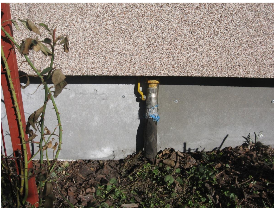
Joonis 17. Eramaja gaasitrassi sulgemiskraan (Autori erakogu)
