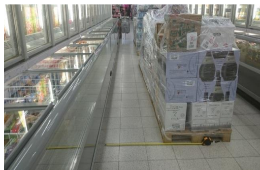
Joonis 9. Lukustatud evakuatsioonipääs ja ladustatud kaubaalused kaubaga Tartu Lõunakeskuses (autori foto)
