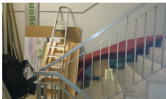
Joonis 6. Evakuatsioonipääsude uksed ja evakuatsioonitrepikoda takistatud Tartu Kaubamajas (autori foto)
