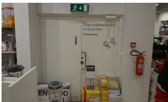
Joonis 6. Evakuatsioonipääsude uksed ja evakuatsioonitrepikoda takistatud Tartu Kaubamajas (autori foto)
