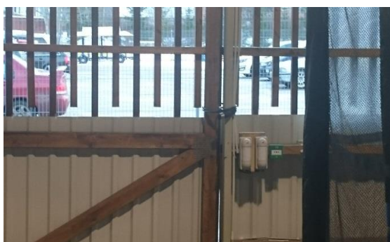
Joonis 9. Lukustatud evakuatsioonipääs ja ladustatud kaubaalused kaubaga Tartu Lõunakeskuses (autori foto)
