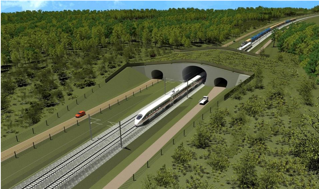
Foto 2. Viadukt üle raudtee (Rail Baltic Info, 2013)
