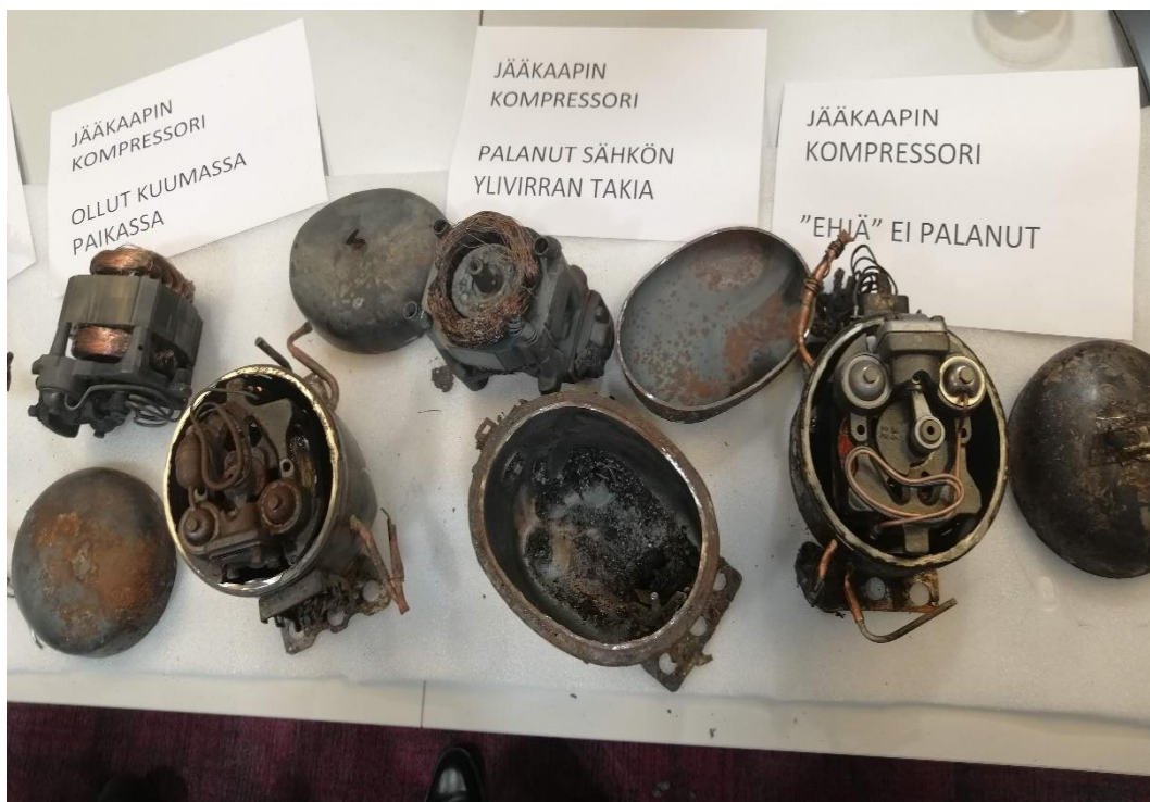
Joonis 1. Külmkapi kompressorite kahjustused (Luht-Kallas, 2019)
