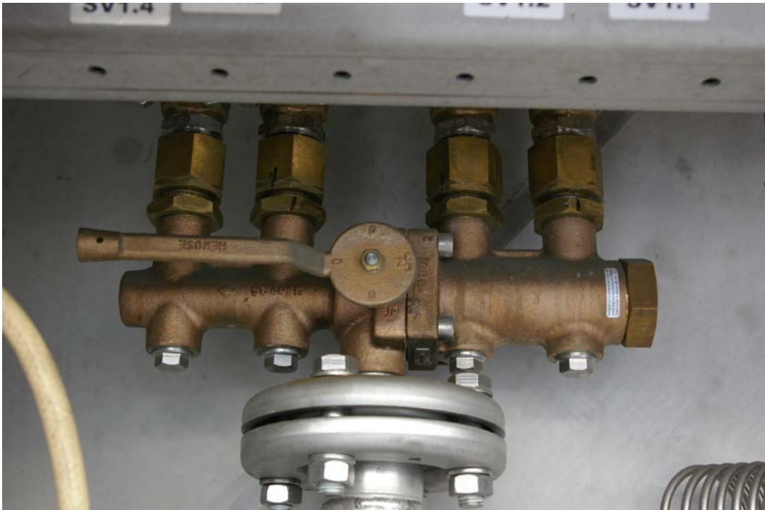
Joonis 12. AS Eesti Gaasi tsisterni ülerõhklappide kolmikkraan. (autori pilt)
