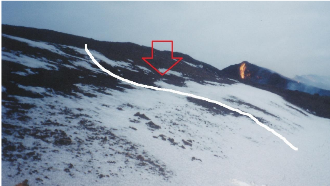
Joonis 4. Isekuumenenud aun. Noolega näidatud kohas on näha, kuidas poolkoksi tekkimise tagajärjel on aun vajunud ja kuumenemise tagajärjel on lumi auna pealt sulanud. (foto G. Leppiku erakogust; autori poolt täiendatud)
