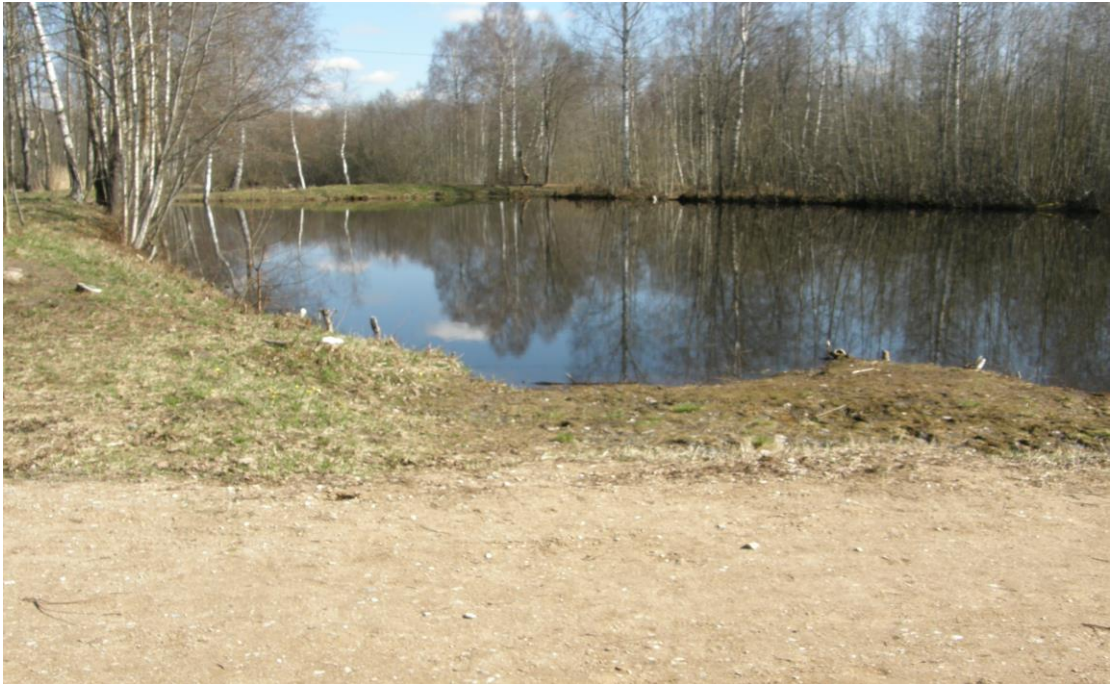
Foto 3. Rapla Vesiroosi Gümnaasiumi veevõtukoht. Autor: S. Falilejev, 20.04.2008.a. Puudub projektijärgne veevõtu platvorm. Vana on lagunened.
