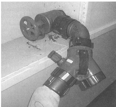
Joonis 9. Tagasivooluklapiga hargmik (McGrail, 2007:214)
