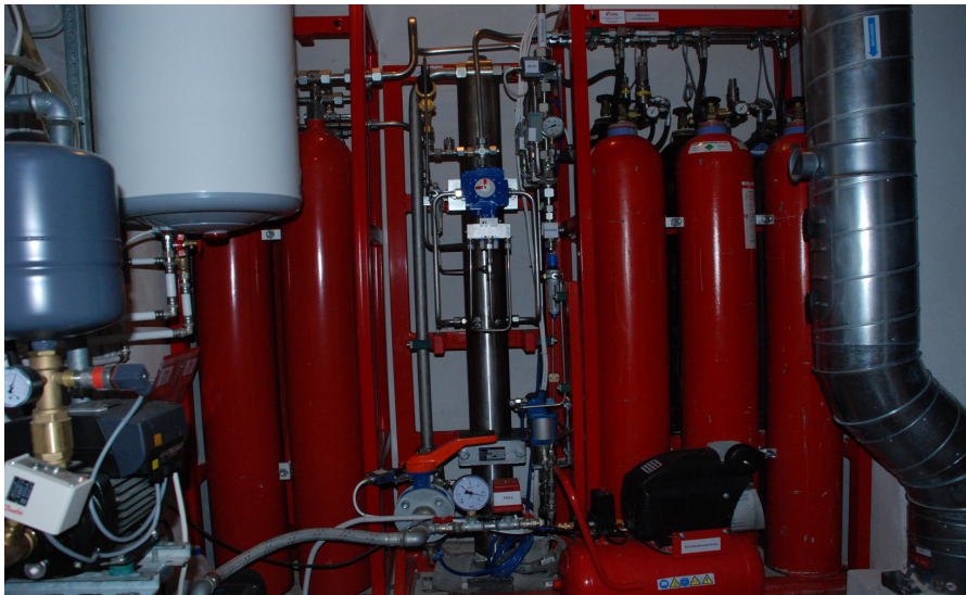
Joonis 2. Veeudu kustutussüsteemi pumbasüsteem
