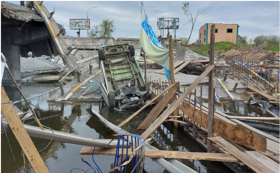
Joonis 6. Purustatud sild Iripini ja Kiievi vahelisel maanteel (Foto autor: Ivo Juurvee)
