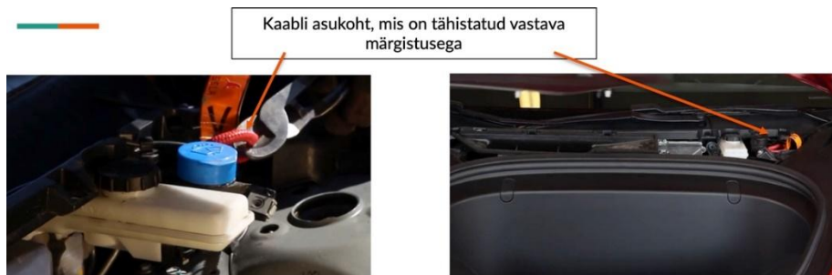
Joonis 12. Tesla kõrgepingekaabli asukoht (Trakmann, 2022)
