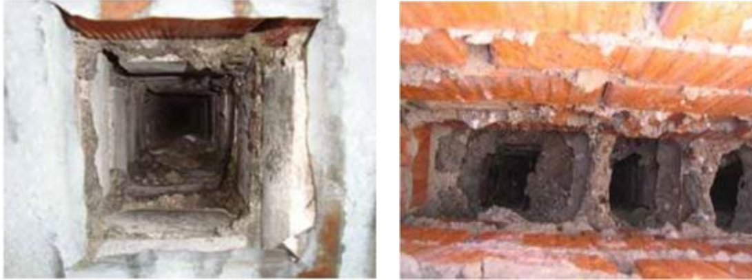
Joonis 3. Ventilatsioonikanalite ehituskvaliteet on halb ning seinad suure karedusega (Tallinna Tehnikaülikool, 2010, lk 118)
