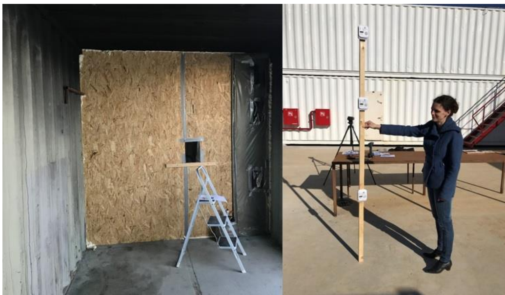
Joonis 10. Vaheseina ehitamine merekonteinerisse ning vingugaasiandurite paigaldamine kolmele kõrgusele (autori tehtud)
