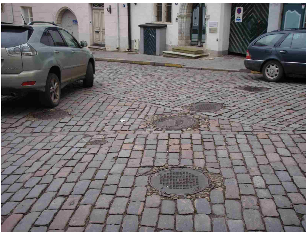
Joonis 9. Kaevuluugid Tallinna vanalinnas (autori tehtud)
